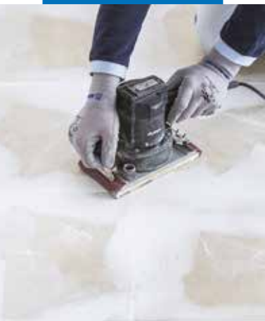
Slibning af overfladen, som er udglattet med Planiprep 4 LVT
