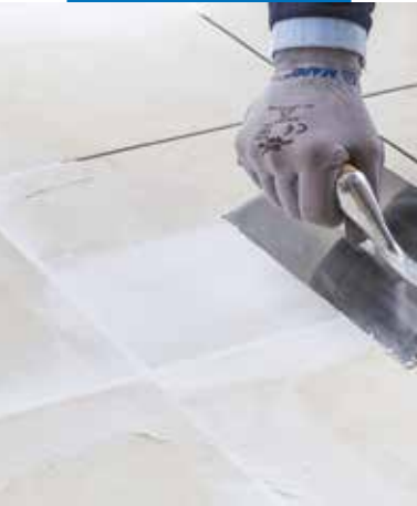
Udglatning og forsegling af fuger i eksisterende keramikgulvfliser med Planiprep 4 LVT
