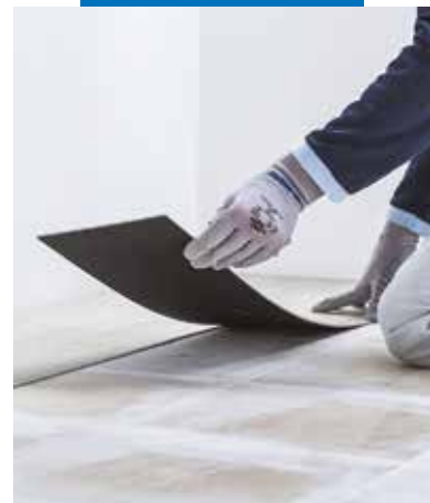
Lægning af selvklæbende LVT over keramikfliser, udglattet med Planiprep 4 LVT
