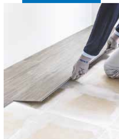
Lægning af LVT klikgulv på keramikfliser, udglattet med Planiprep 4 LVT
